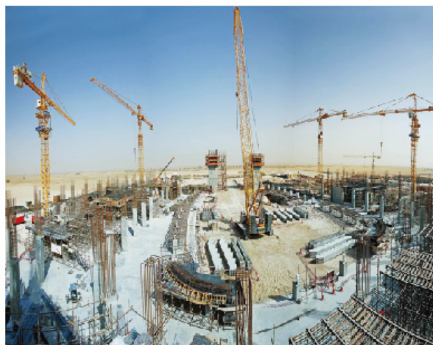
大型建筑工程
