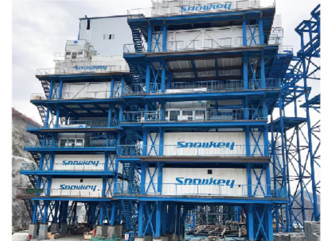
中国能建葛洲坝二公司智能建造示范项目——QBT项目
