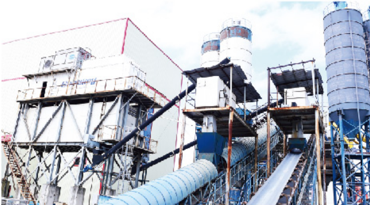
深中通道项目
