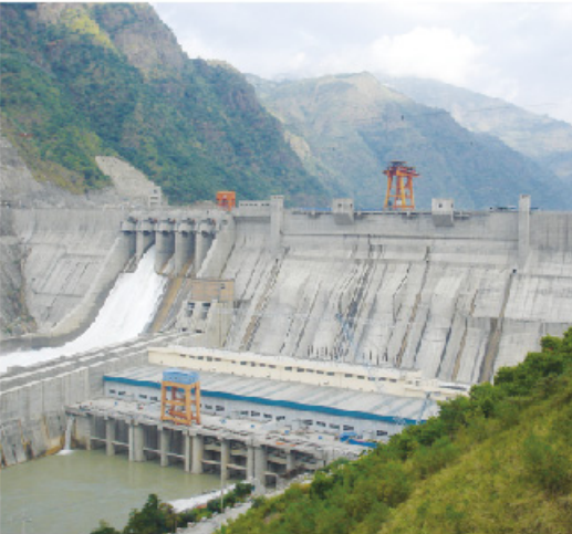
金安桥水电工程
