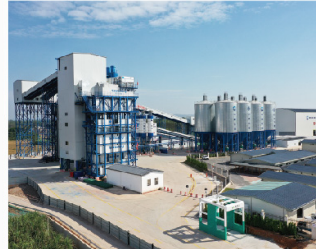
新中国第一条运河工程——平陆运河项目
