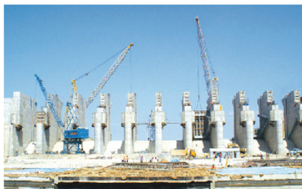
水利大坝建设工程
