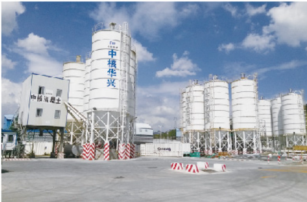
阳江核电工程
