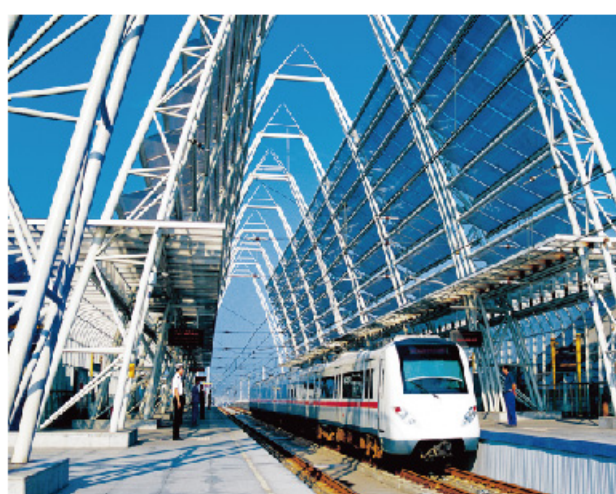
城市轻轨建设工程
